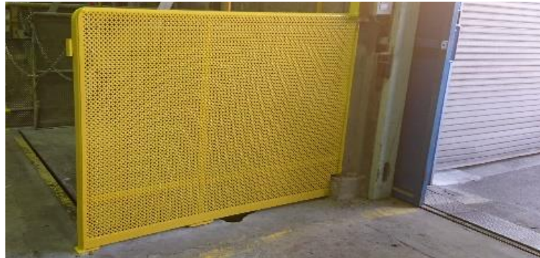
【修理後の安全柵】
