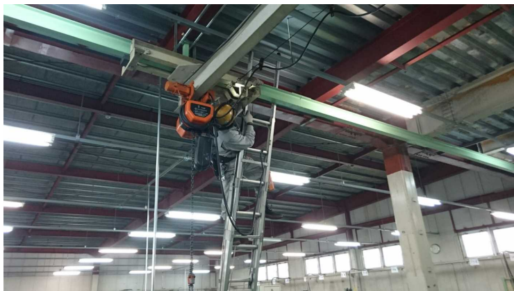
【チェーンブロック点検メンテナンス状況】
