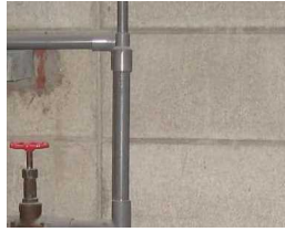
<バルブ取付 工事前>
