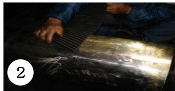
2. 下地のプライマー塗った 後、接着剤にて貼り付け
