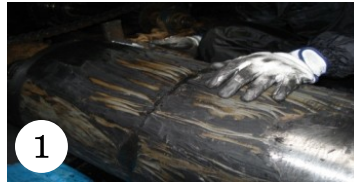
1. ゴムライニングのテールプーリー 荒削り カッターにてゴムを剥ぎ、 グラインダーにて表面仕上げ
