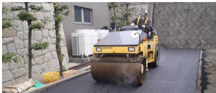
＜駐車場アスファルト舗装＞
