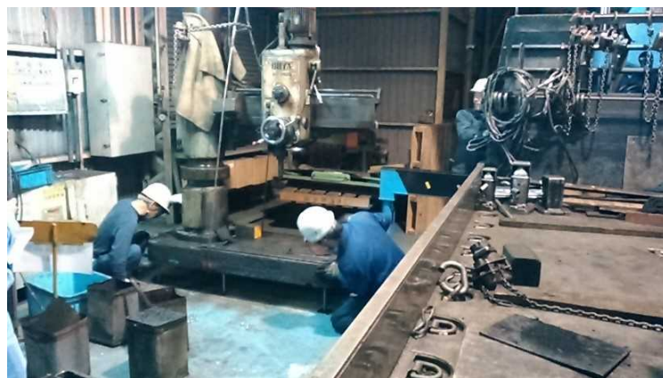
【修理・メンテナンス・据付作業風景】
